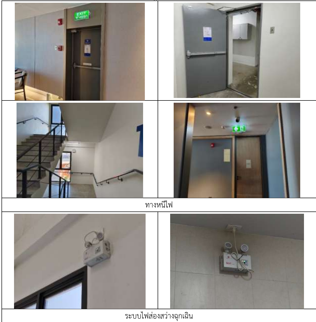
รูปที่ 2-15 ระบบป้องกันและระงับอัคคีภัย (ต่อ)
