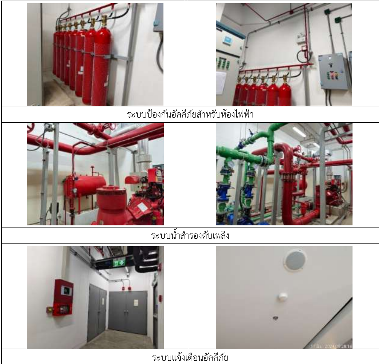
รูปที่ 2-15 ระบบป้องกันและระงับอัคคีภัย (ต่อ)
